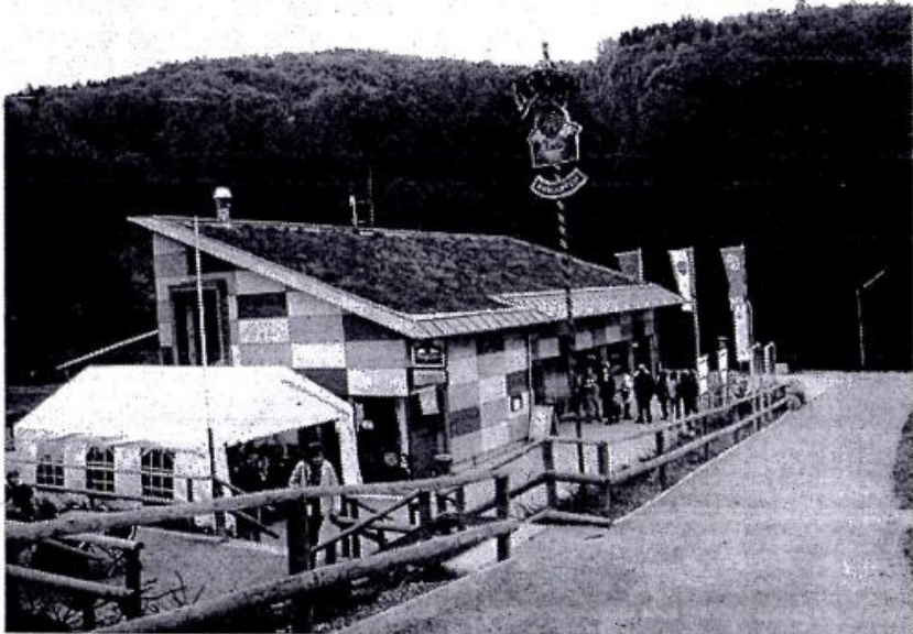
緑あふれる地域の公共施設の屋根にも、植栽が施されている
