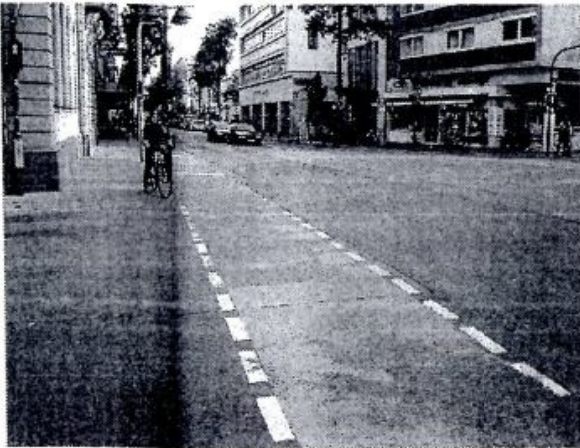
歩道が途切れても、自転車専用レーンが設けられている道路
